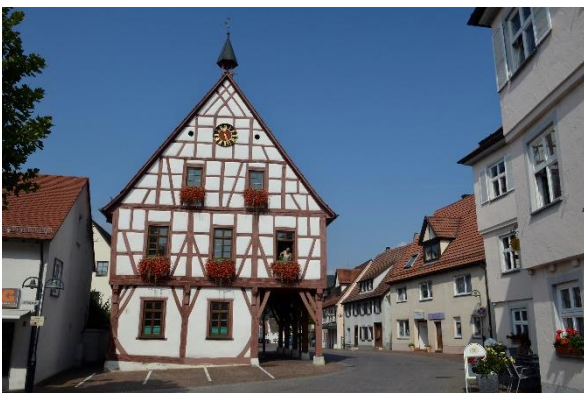
Altes Rathaus Fachwerkbauten 15. bis 19. Jh.
